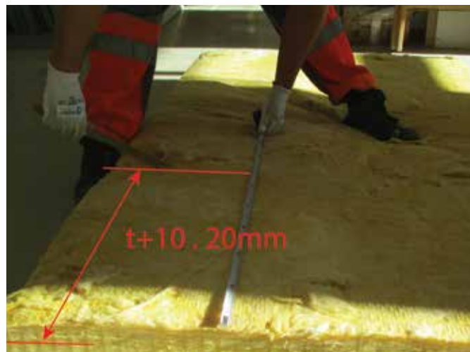
Figura 15. Tăierea unei bucăți de vată minerală pentru stratul dintre căpriorii unei zone de acoperiș
