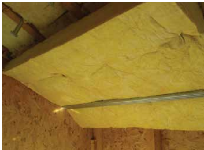
Figura 21. Montarea profilului CD 60/27 în ancore
