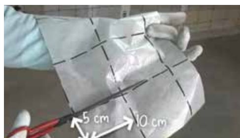
Figura 48. Decuparea bucății de membrană pentru etanșarea străpungerii cu o tubulatură
