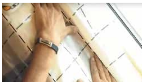
Figura 44. Introducerea membranei în șanțul ramei ferestrei
