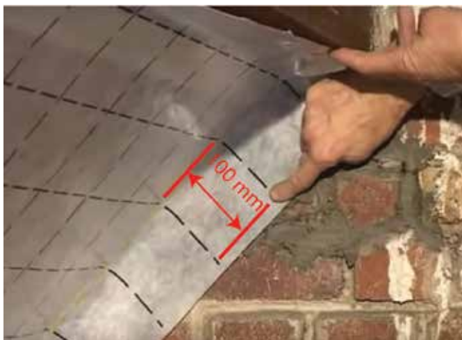
Figura 31. Zona de joncțiune dintre șarpantă și calcan
