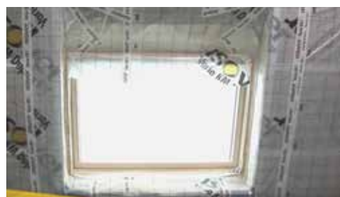
Figura 45. Golul ferestrei de mansardă după aplicarea membranei ISOVER Vario® KM Duplex UV
