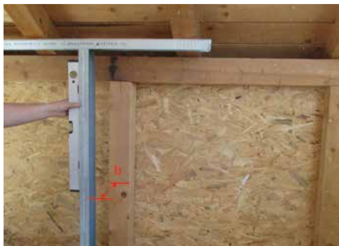
Figura 6. Montarea profilului Rigiprofil® UW pe planșeu.
