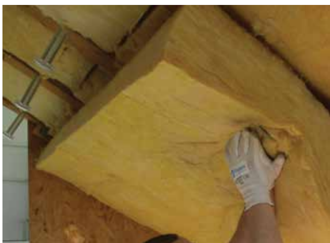
Figura 19. Montarea stratului de vată minerală sub căpriori
