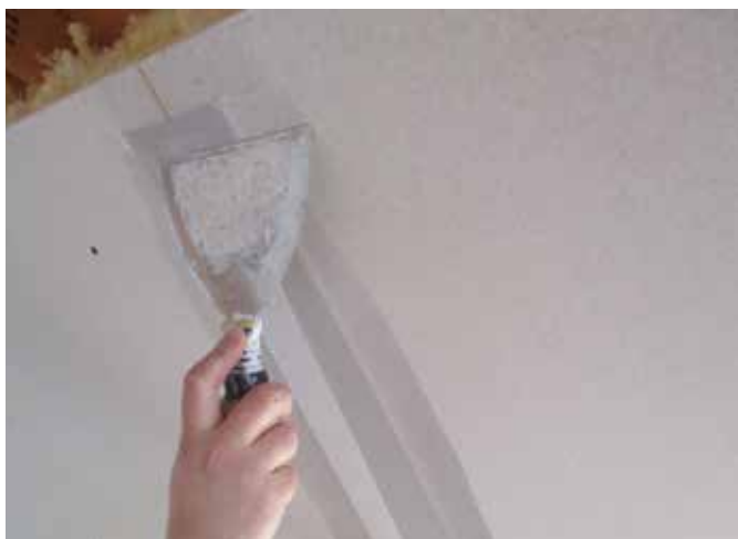
Figura 68. Aplicarea benzii de armare la îmbinarea dintre plăcile din gips-carton
