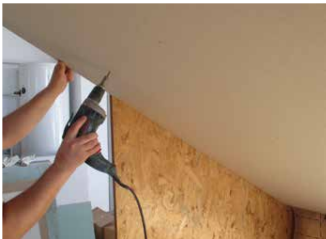
Figura 57. Montarea plăcilor din gips-carton
