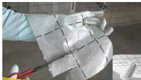
Figura 47. Decuparea bucății de membrană pentru etanșarea străpungerii cu o tubulatură
