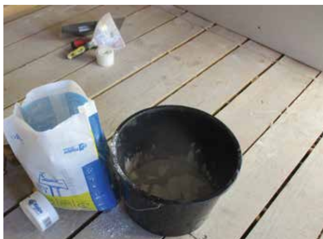
Figura 65. Produse și unelte folosite pentru chituirea rosturilor
