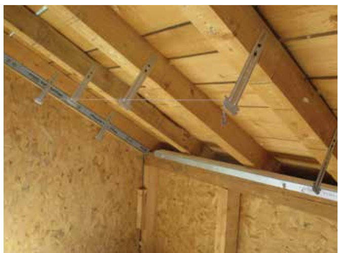
Figura 11. Ancore aliniate pe un nivel
