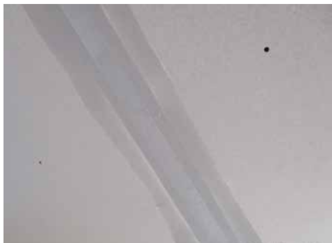
Figura 69. Aplicarea benzii de armare la îmbinarea dintre plăcile din gips-carton
