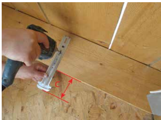
Figura 8. Montarea ancorelor pe căprior
